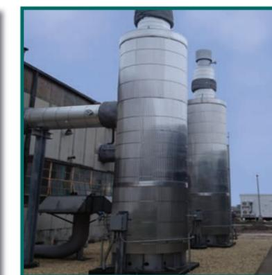
*DCL construit des silencieux catalytiques pour des nouvelles installations ainsi que des silencieux catalytiques pouvant s'adapter à des installations existantes (mise en conformité des installations).*
